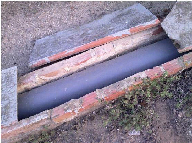
Rec d'obra reconvertit a canonada de plàstic, tapat amb peces d'obra
