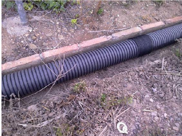
Rec d'obra reconvertit en canonada de plàstic
