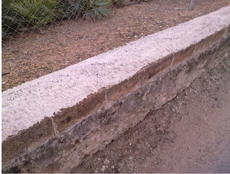
Rec d'obra reconvertit en canonada, tapat amb formigó
