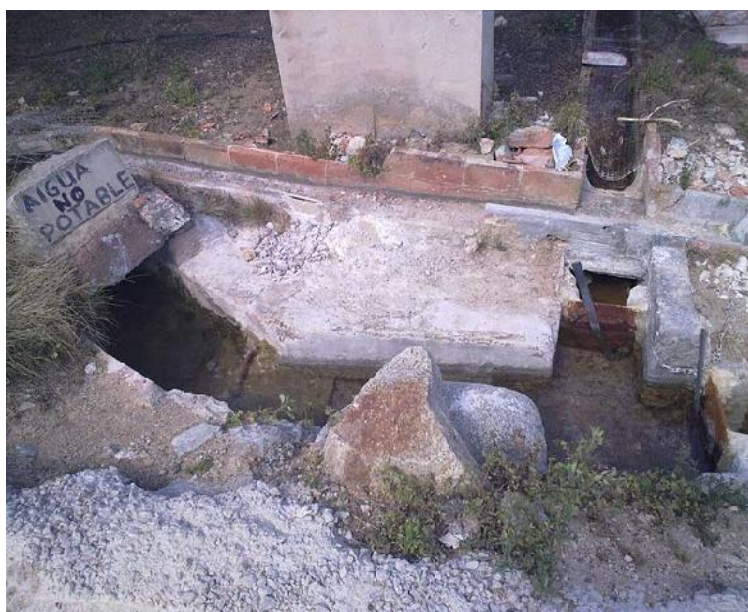
Mina de Sant Pau
